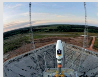
Contrôle de terrassements Base de lancement Soyouz Guyane
