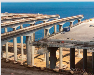
Contrôle des fondations Aéroport de Madère Portugal
