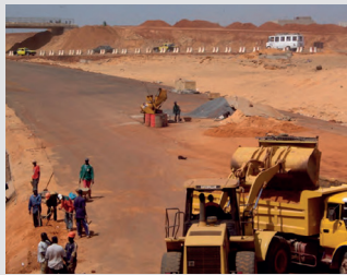
Contrôle de terrassements autoroutiers Pikine Sénégal
