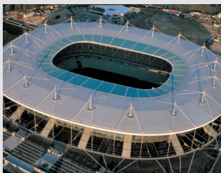
Contrôle des fondations Stade de France France
