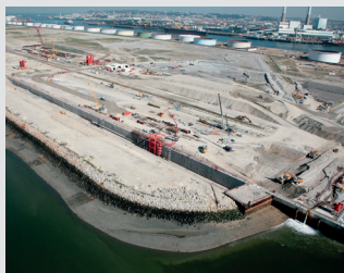
Contrôle externe du quai de 2100 mètres Port du Havre France
